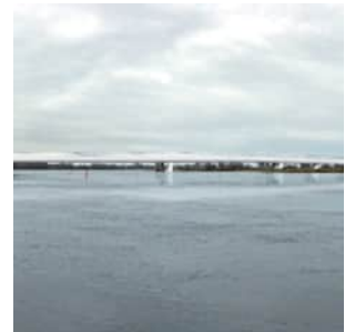
Neubau Elbebrücke ©KRP
