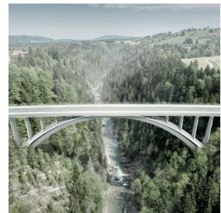
Echelsbacher Brücke ©KRP
